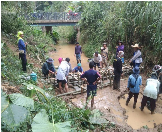
สร้างฝายชะลอน้ำ พื้นที่ตำบลหมอเมือง
