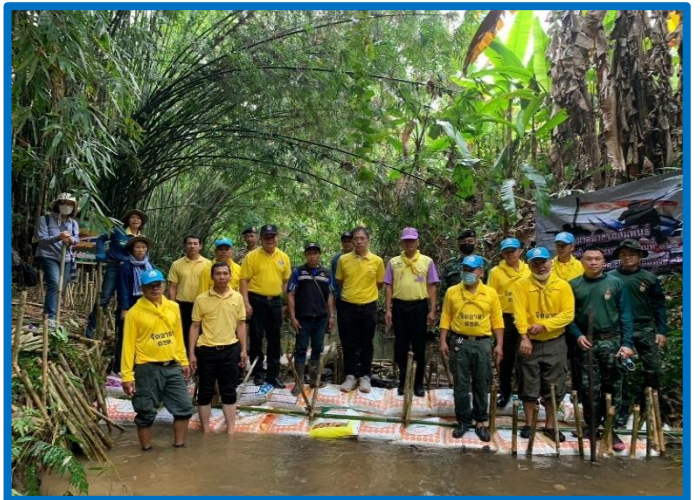
สร้างฝายชะลอน้ำด้วยกระสอบทราย
