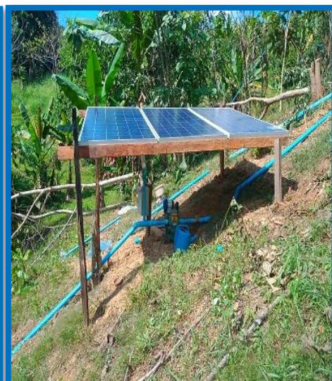
การใช้พลังงานทดแทนโซล่าเซลล์ในการสูบน้ำจากฝายแกนดินซีเมนต์
