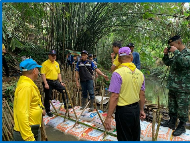
สร้างฝายชะลอน้ำด้วยกระสอบทราย
