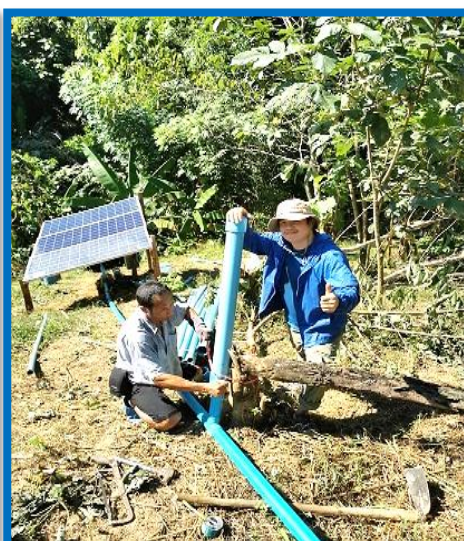
การใช้พลังงานทดแทนโซล่าเซลล์ในการสูบน้ำจากฝายแกนดินซีเมนต์
