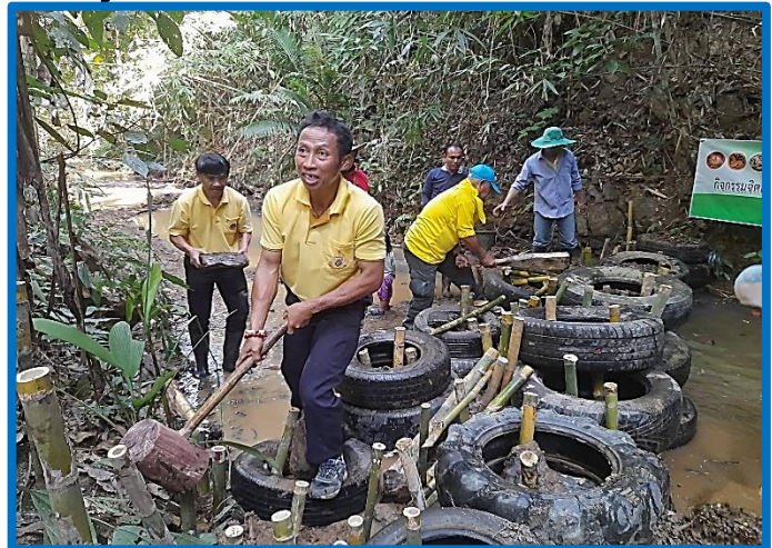
สร้างฝายชะลอน้ำด้วยยางล้อรถยนต์
